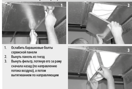
Рис. 59 – замена фильтрационной вставки
