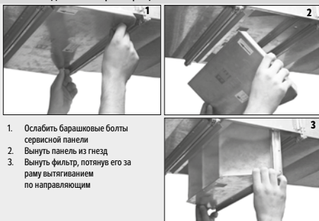
Рис. 60 – демонтаж фильтрационной вставки
