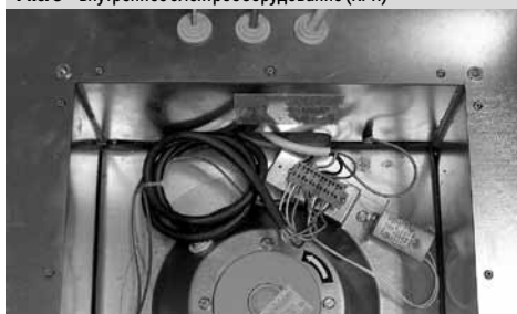
Рис. 10 – клеммная коробка и конденсатор (одноф. двигатель)
