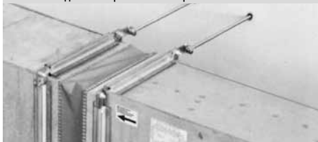
Рис. 13 - подвеска на резьбовые стержни
