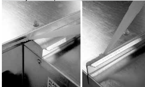
Рис. 10 – уплотнение крышек
