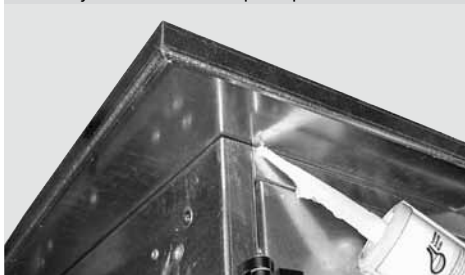
Рис. 13 – уплотнение нижней стороны крышки
